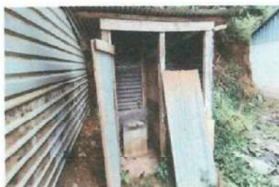
Foto 5: SANITARIOS EN PESINAS CONDICIONES SE SUSTITUIRA LAS PAREDES DE LAMINA POR BLOCK
