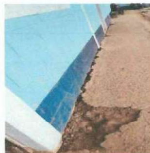
Foto 6: Sustitución de corredor ya que se encuentra en mal estado
